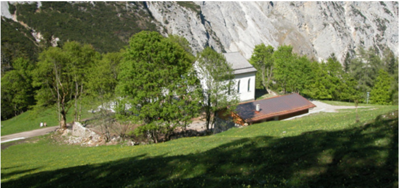
Abb. 1: Blick auf das ehemalige Augustinerinnenkloster St. Magdalena im Halltal in Richtung Nordost. Links Ruine eines Wirtschaftsgebäudes, rechts das heutige Wirtschaftsgebäude mit Auffahrtsrampe von Osten (Hintergrund rechts), in der Mitte die Kirche mit dem kleinen Friedhof, dahinter anschließend Klostergebäude, heute Gastwirtschaft, rechts der nach Süden ansteigende Hang, an dem die Grabungen stattfanden..
