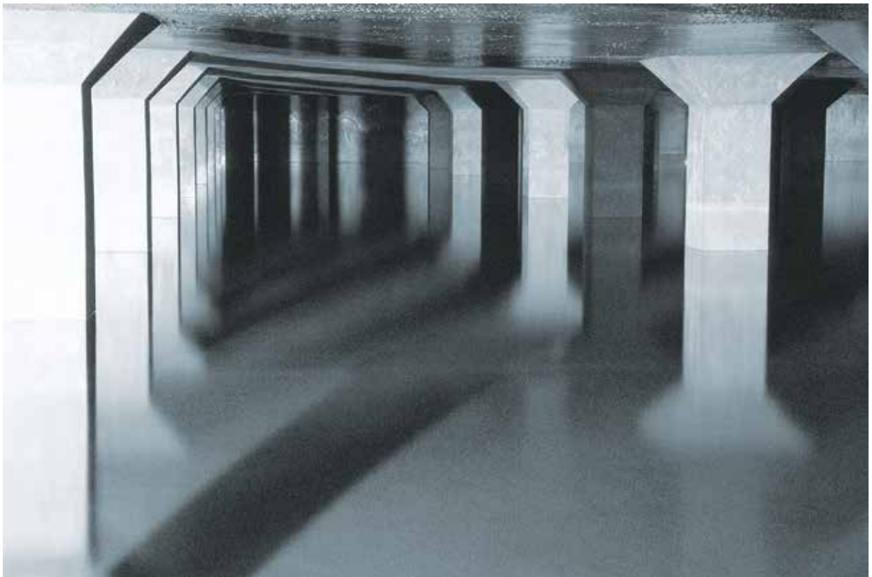
Abb.20: Das „weiße Karwendelgold“ Trinkwasser: Wasserfang in Stollen und Speicherung in Kavernen bei Mühlau, Innsbruck am Fuß der Nordkette (Fotos: IKB Innsbruck).
