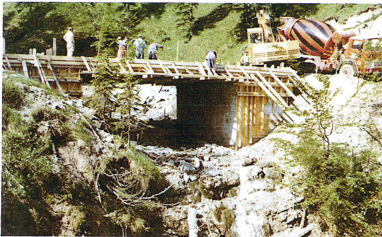
Bau der Brücke über die Erzlaine (Aufnahme vom 3. Juli 1973). (Foto: Archiv Wasserwirtschaftsamt Weilheim)
