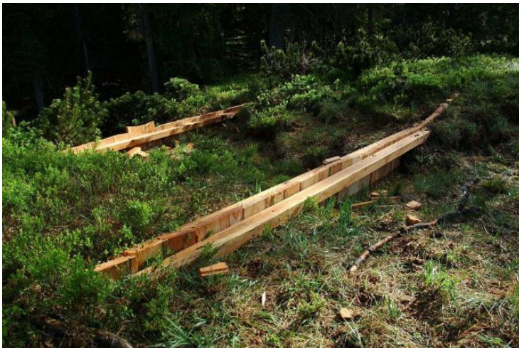
Abb. 9: Fertiggestellte Dämme im Halslkopf-Moor (Quelle: G. Haselwanter)
