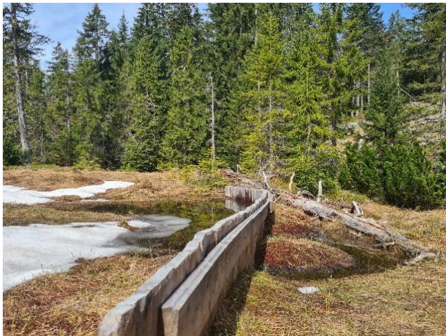
Abb. 16: Neuester Damm, Bau im Okt. '21 (Quelle: Eigene Aufnahme)
