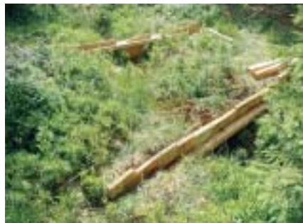
Fertige Dammkonstruktion mit Querbalken zur Verstärkung.
