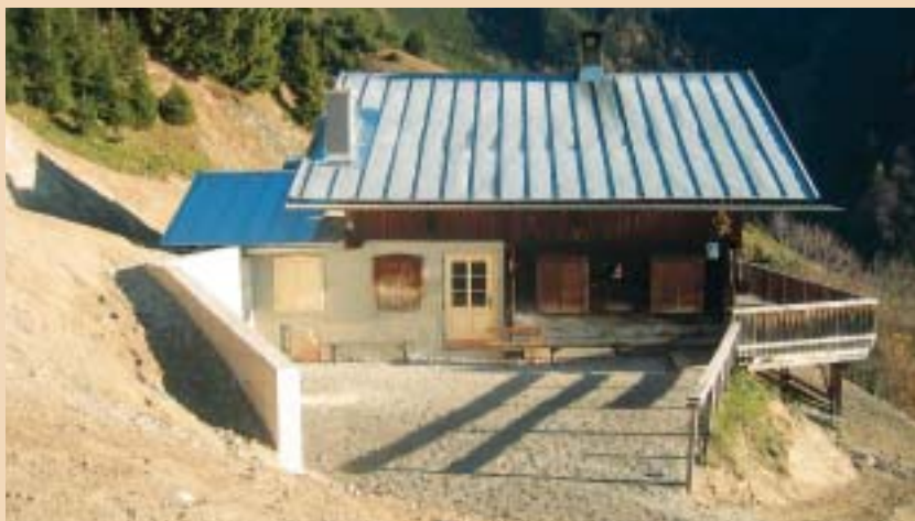
Steigende Erfordernisse haben den Umbau der Thaurer Alm unumgänglich gemacht.
